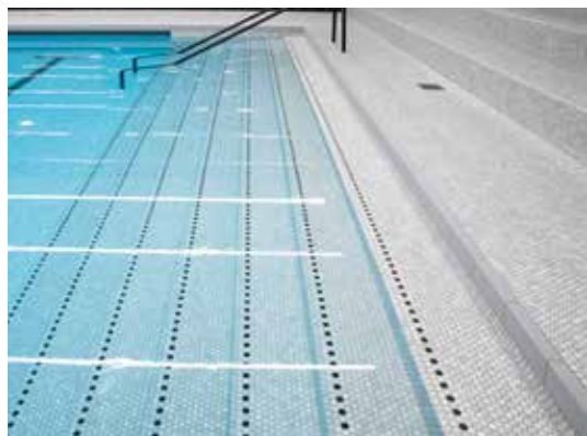
Piscine scolaire Vogelsang de l'école primaire, Bâle, Suisse Architecte : MET Architekten GmbH SIA, Bâle, Suisse Séries : Système de tête de bassin Wiesbaden, Gamme spéciale pour des piscines, Chroma Pool, Loop Photo : Daniel Zehnder
